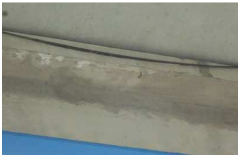
Rys. 14. Wysunięta ciągła podkładka elastomerowa, [źródło własne]
