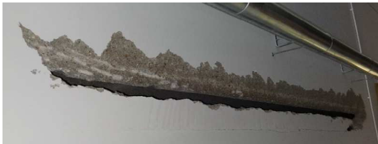
Rys. 8. Przygotowana do naprawy płyta kanałowa, [źródło własne]
