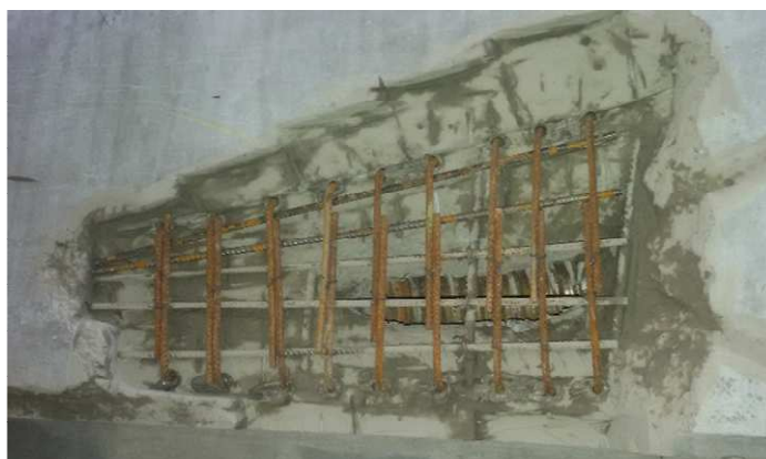
Rys. 6. Przygotowany do zalania uszkodzony fragment słupa, [źródło własne]
